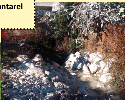
Stabilisation du talus et du fossé rue du Levant par enrochement
