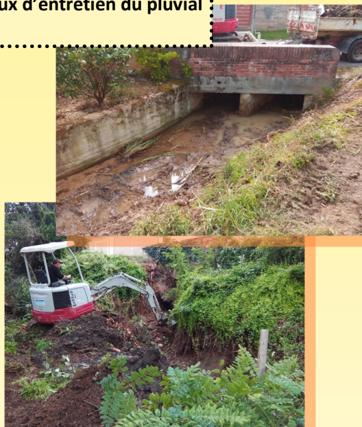
Travaux d'entretien du pluvial
