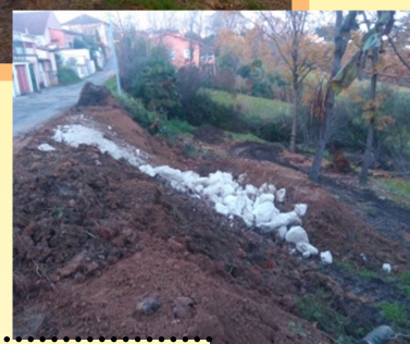
Stabilisation du talus et du fossé rue du Levant par enrochement
