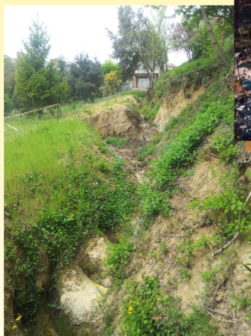
Stabilisation du fossé du Cantarel par enrochement
