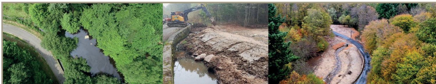
Vues drone : avant pendant et à la fin des travaux
