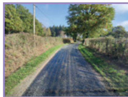
Réfection voirie Entreprise ADN
