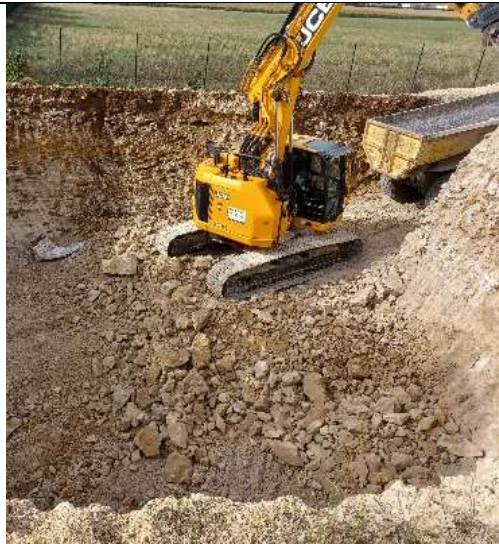
Terrassements pour le bassin tampon du poste des Combes à Chauray
