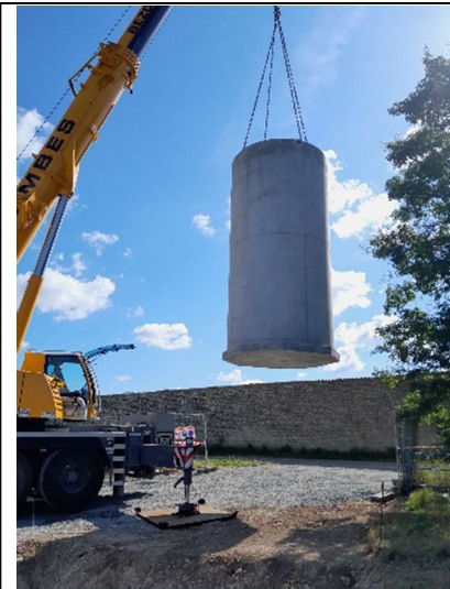
Pose du silo concentrateur de boues à la station de beauvoir sur Niort
