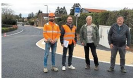
Jean-Marie Turpault et Marcel Poupin avec les responsables du chantier, lors de la dernière réunion sur place, rue des Granges. (Photo : Ouest-France)
