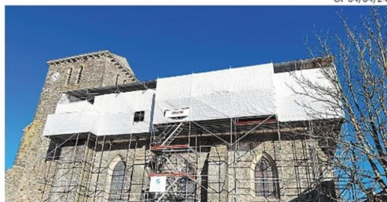
Le chantier de l'église du Breuil-Barret a mobilisé quelque 540 000 € HT de travaux sur deux exercices. L'inauguration est annoncée pour septembre.
