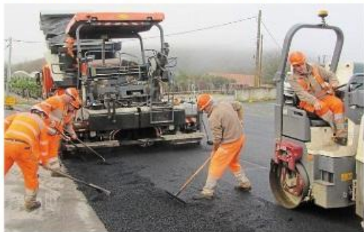
L'entreprise Colas a été chargée des travaux de voirie pour 2024. Vendredi matin, la pose de l'enrobé commençait sur la route du Plessis-Robineau. (Photo : Ouest-France)
