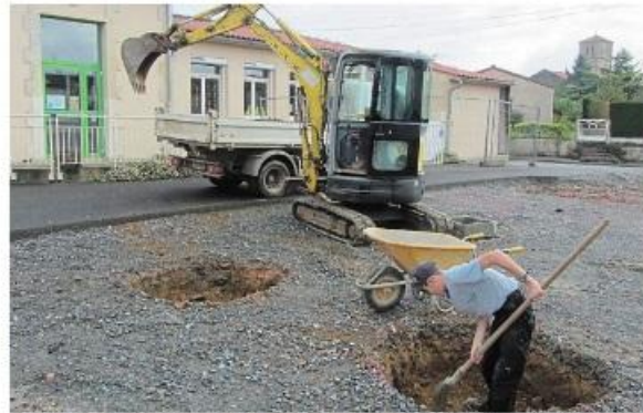
Les travaux de renaturation de la cour de l'accueil de loisirs intercommunal Laguéprie ont commencé.
