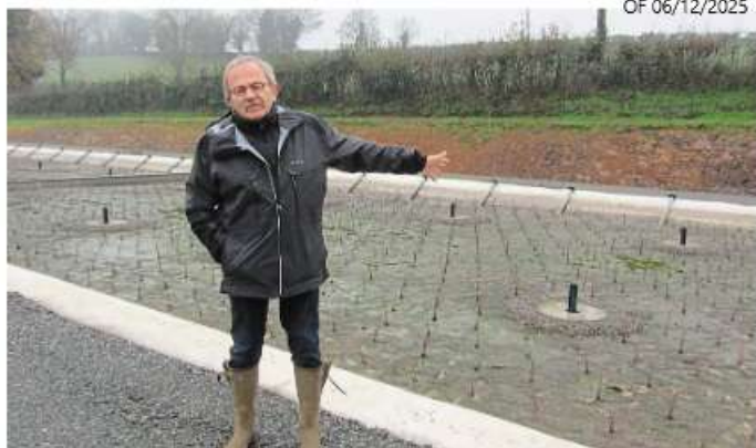
Louis-Marie Briffaud, maire délégué de Breuil-Barret, au bord d'un des bassins de filtration plantés de roseaux sur un lit de gravier et de sable. Une évolution écologique pour le traitement des eaux usées. PHOTO: OUEST-FRANCE
