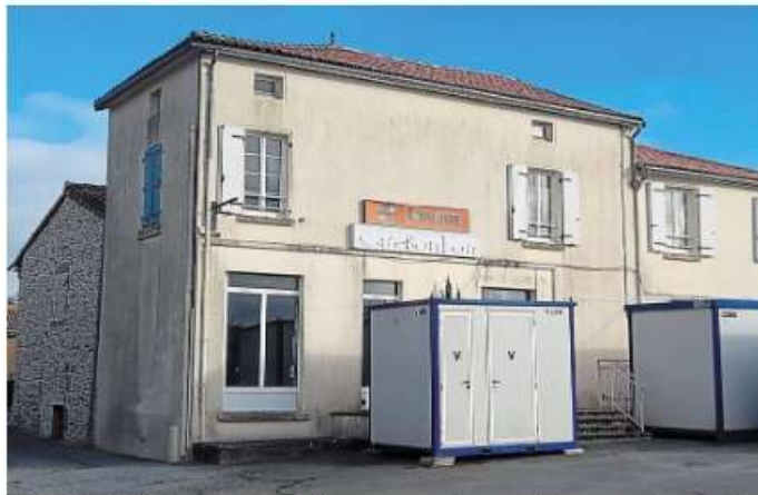
Des travaux de réhabilitation sont en cours sur ce bâtiment communal qui abritera bientôt un commerce. La municipalité a fait le choix de recouvrir les deux façades côté rue d'une grande fresque bleu nuit avec l'image de la spatonaute Claudie Haigneré.
