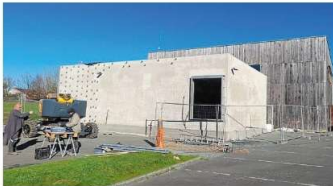
Les travaux d'extension de la salle Ostaderia approchent de leur terme. La commune doit souscrire un emprunt pour les financer, comme prévu au budget 2025. | PHOTO : OUEST-FRANCE
