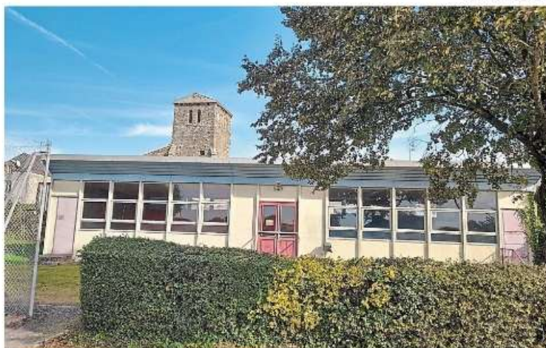
S'il se réalise, l'aménagement d'une aire de vélo tourisme au cœur du bourg de Breuil-Barret nécessitera la démolition de l'ancien foyer de jeunes. (Photo : Ouest-France)
