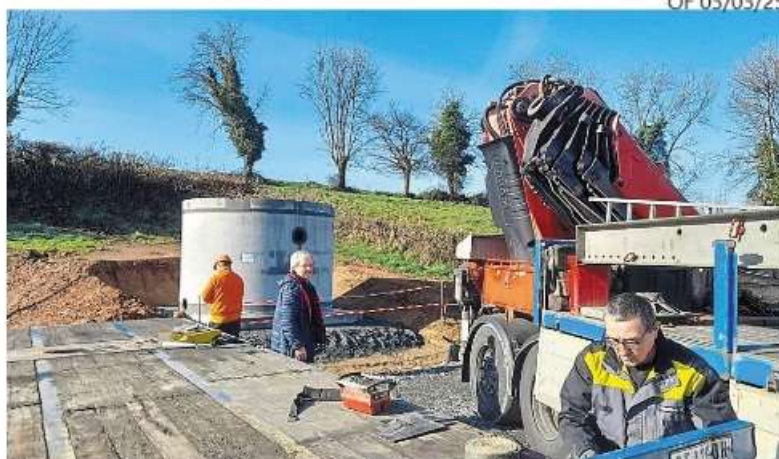
Le budget assainissement s'équilibre à 1 126 436 €. Le plus gros morceau est l'agrandissement en cours de la station du Breuil-Barret. Jeudi 27 février, une entreprise de Montagne-sur-Sèvre est venue mettre en place deux cuves, de 5 tonnes chacune, destinées au fonctionnement de l'extension de la station.
