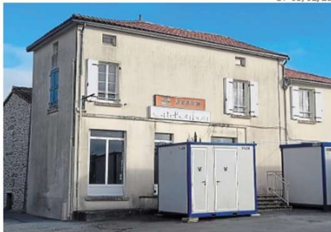
Dans le bourg de La Chapelle-aux-Lys, le café-restaurant va bénéficier de travaux de réhabilitation énergétique. Les élus ont validé le montant de la location aux nouveaux gérants.
