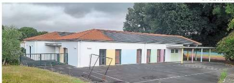
L'ancienne école privée Soeur Emmanuelle de Breuil-Barret et celle de La Chapelle-aux-Lys vont passer dans le giron communal pour 200 000 €, net vendeur.
