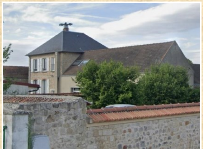
Vues des façades arrière
