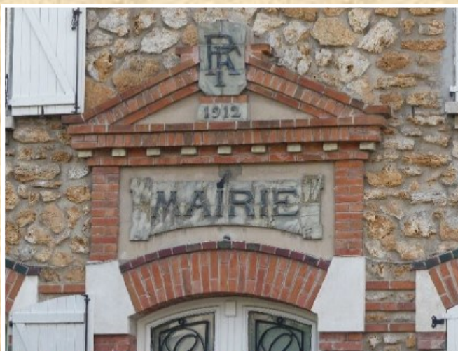
Détails du fronton portant la date de construction
