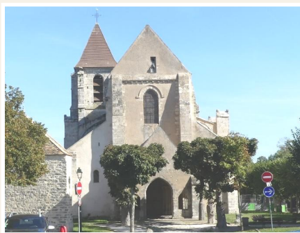
La façade ouest de l'église, avec sa façade pignon et le narthex du
