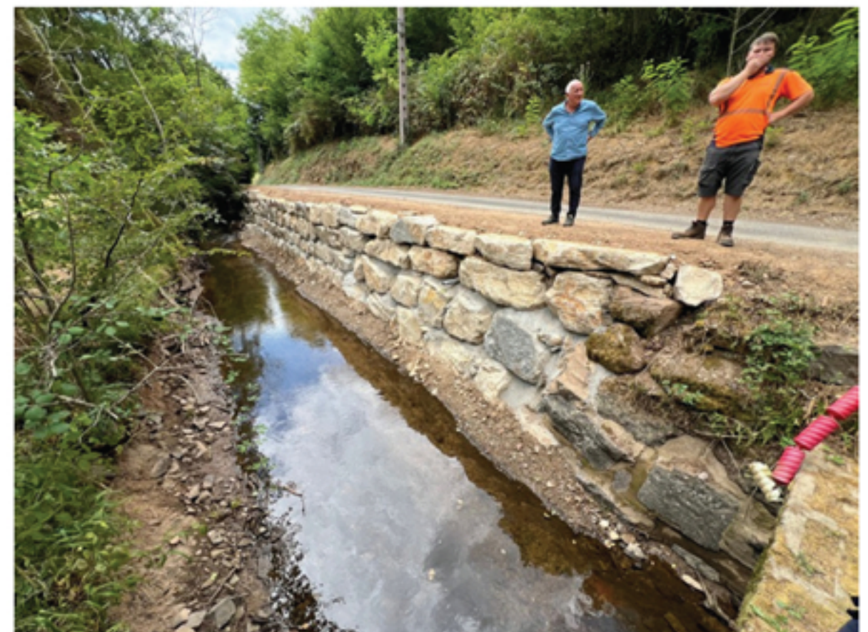
Enrochement impasse du Moulin du Sapinier
