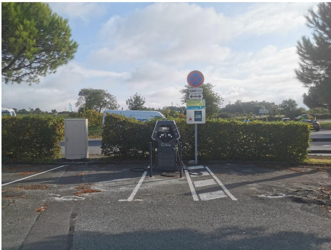
Borne de recharge électrique à Beaulieu-sur-Layon
