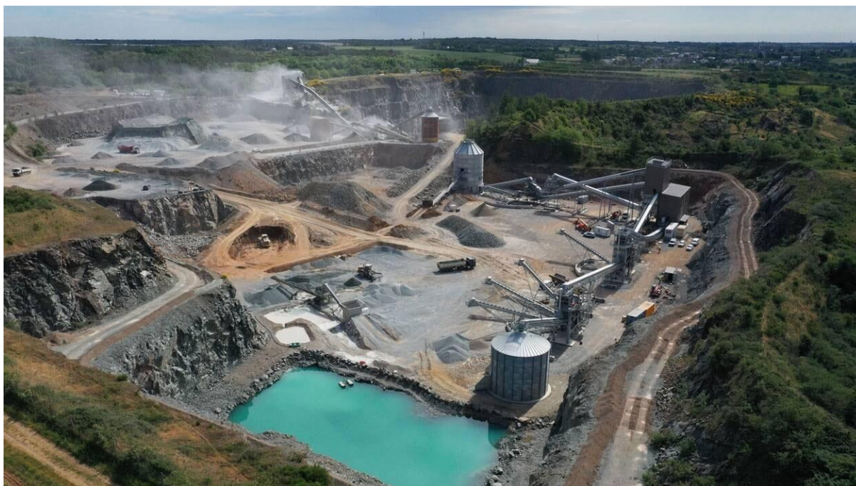
Photo 2 : Carrière de Pierre-Bise - PHOTO CO - JOSSELIN CLAIR
