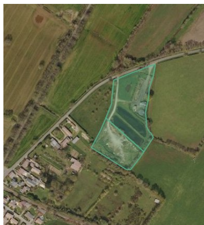
Station d'épuration du Bourg
