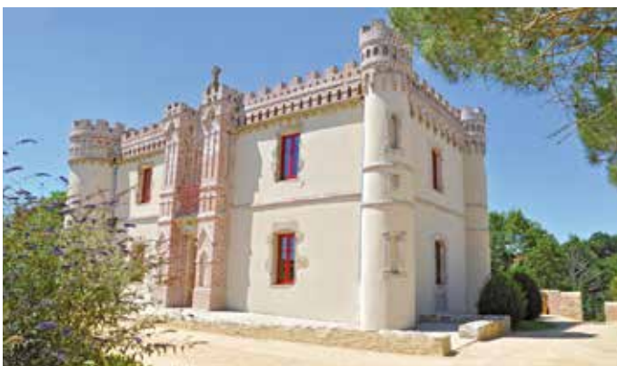
Relookage du Château Gaillard.
