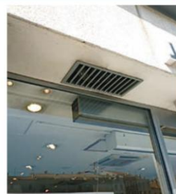
La grille de ventilation du climatiseur est placée dans la maçonnerie.
