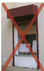
Coffre volet roulant en porte-à-faux sur la rue.
