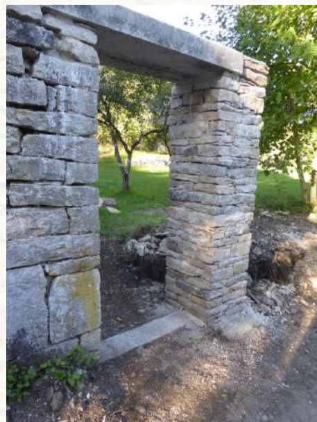
La porte restaurée
