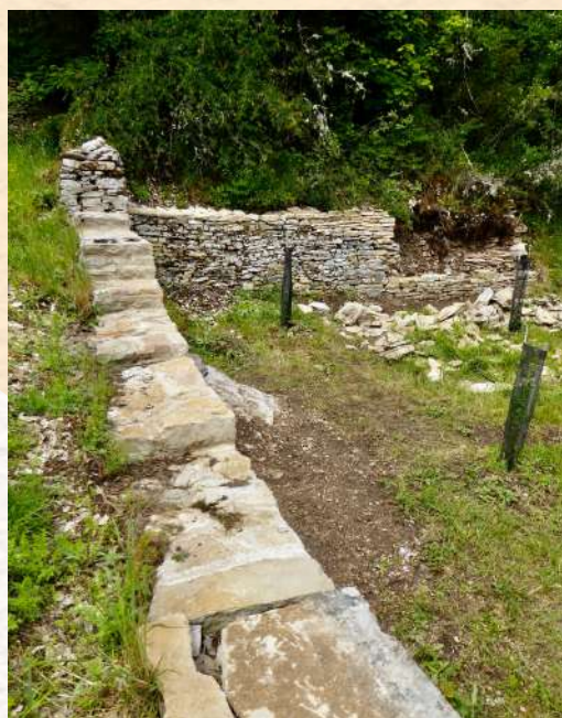
Consolidation du mur de soutènement
