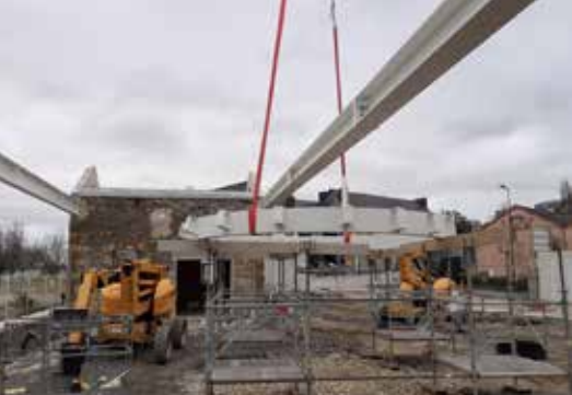
Travaux des Halles-Marché / Avril 2024
