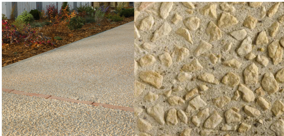
Béton désactivé couleur beige clair Gravillon concassé calibre 20/40 mm, pour les trottoirs
