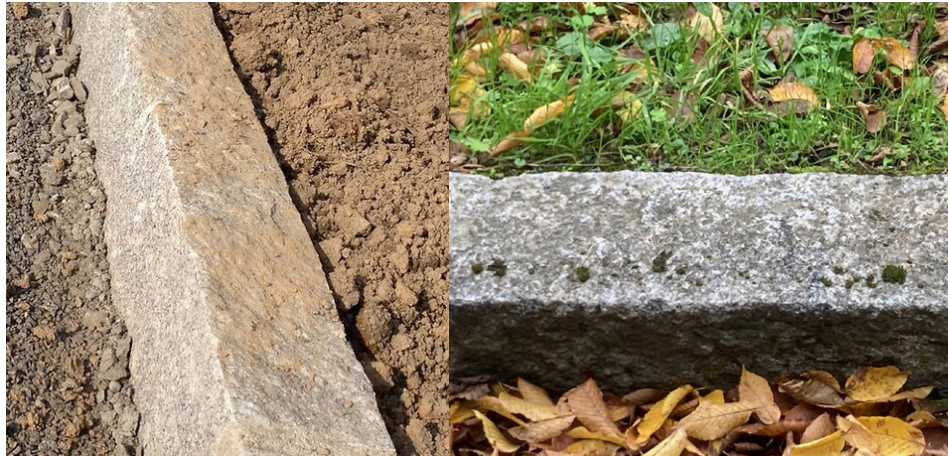
Bordure granit semi-smillé Largeur (15 cm) et vue (+ 0 à + 4 cm) selon localisation de l'espace
