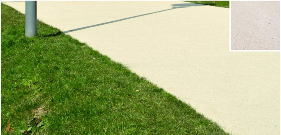
Sable stabilisé renforcé couleur beige clair Sable 0/6, pour le square place du Piloni
