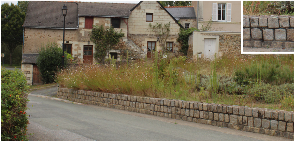
Pavés granit, fourniture ou réutilisation Pour caniveau pavé
