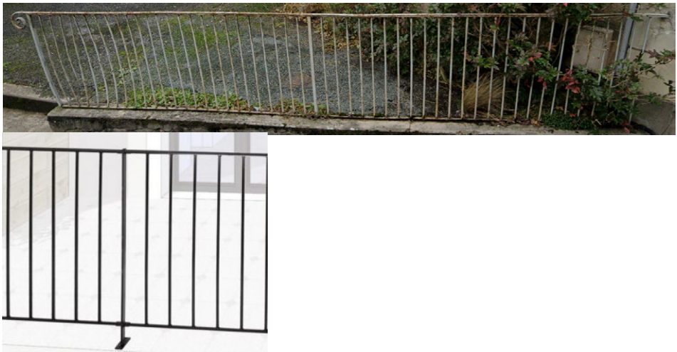
Garde-corps Restauration garde-corps, thermolaquage 7016 Remplacement du garde-corps, thermolaquage 7016
