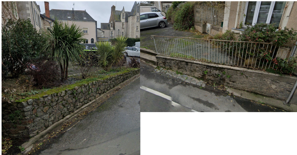
Mur de soutènement existant Conservation, nettoyage et reprise des joints Remplacement du garde-corps ou restauration
