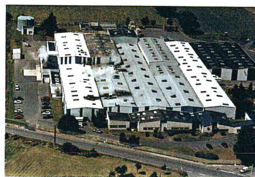
Le site des Celluloses de la Loire à Allaire (56).
