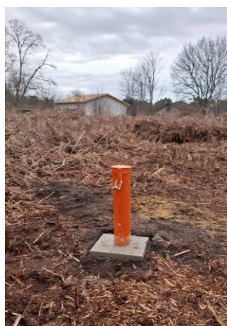
Figure 10 : Photographie du piézomètre PZ1 (Réalisation : CERAG)
