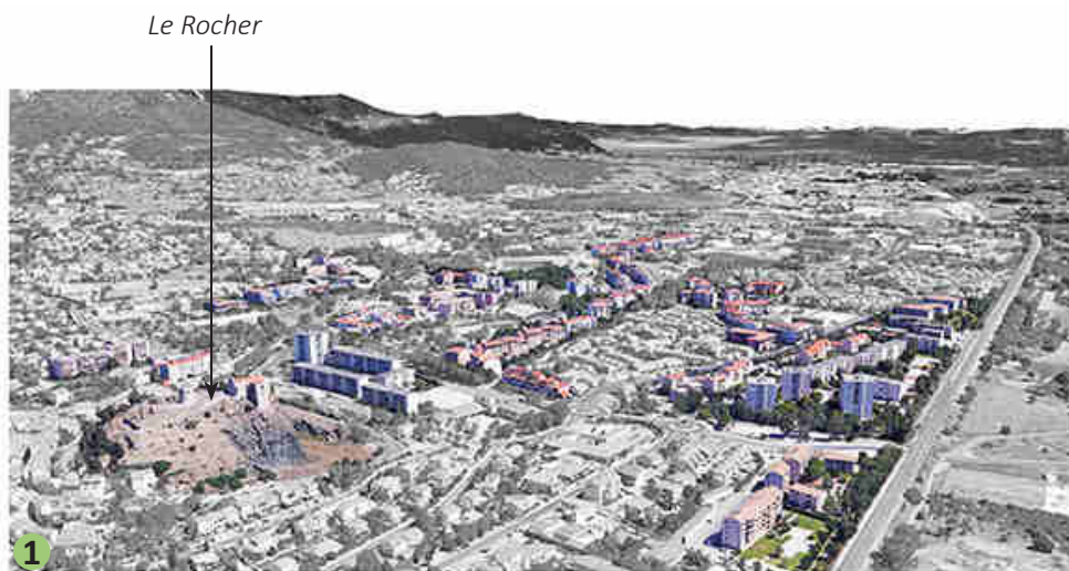
1 Les quartiers d'habitat collectif de la partie nord de la commune (vue vers les terres).
