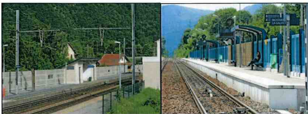
Exemples d'écrans acoustiques à Aiguebelle et Moirans
