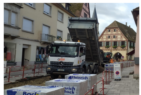
Travaux de remplacement des pavés au centre-ville
