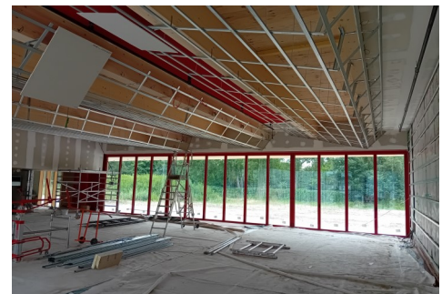
Le chantier du complexe culturel avance
