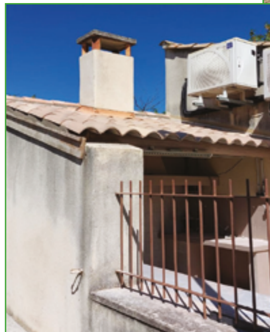
Septembre 2025 - Réfection de la toiture du local de l'OMSC
