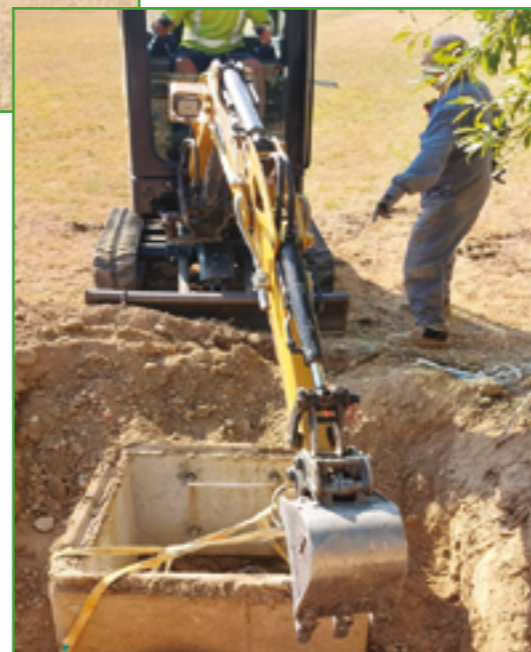
Août 2025 - Réparation de l'arrosage du stade municipal
