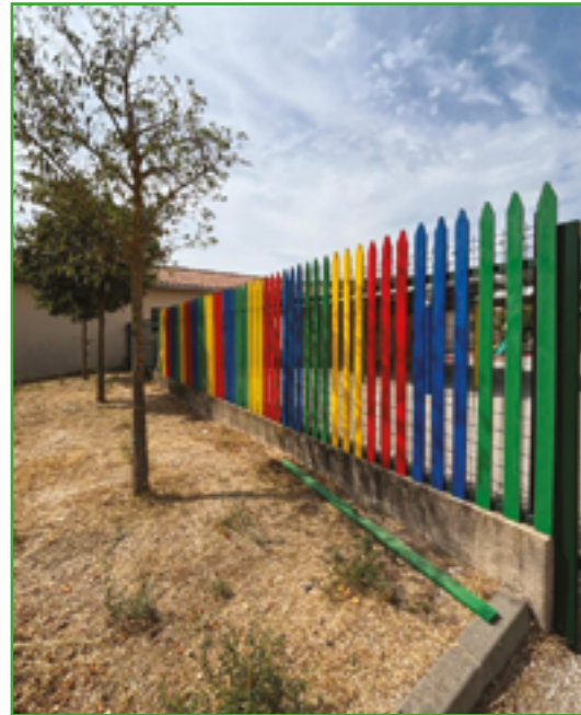
Août 2025 - Réalisation par les services techniques d'une palissade colorée pour la cour de maternelle
