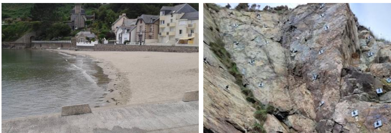
Figure 6 : Perré et mur de soutènement à Bréhec Plage et tirants d'ancrage sur la Plage Bonaparte
