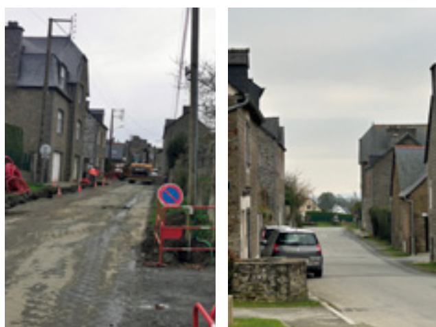
Rue du Chêne Huby : travaux toujours en cours
