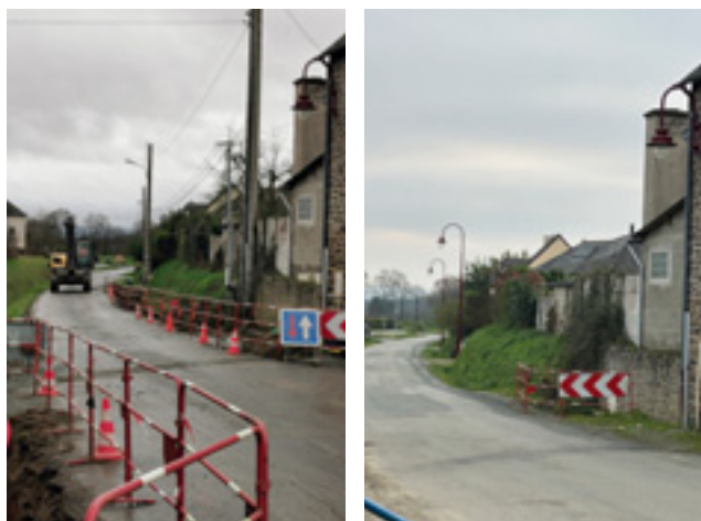
Rue de l'Oisellerie : travaux terminés en Novembre
