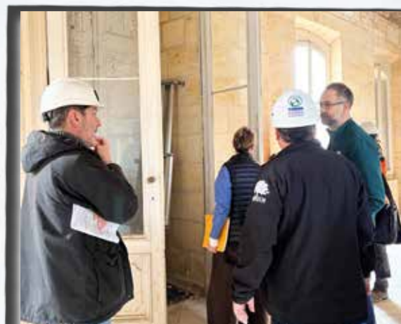
Chantier du Pôle Educatif de la Séguinie : les menuiseries sont récupérées pour être réutilisées.
