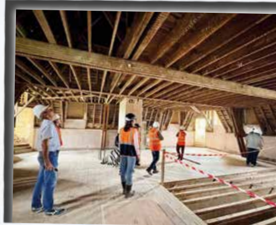
Visite de chantier dans le château de la Séguinie.
