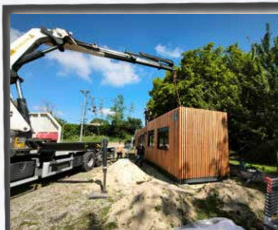
Installation du Chalet d'Hippolyte au boulodrome.
