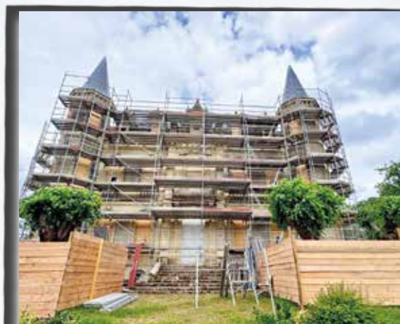
Le chantier du Pôle Educatif de la Séguinie avancement avec l'installation de l'échafaudage !
