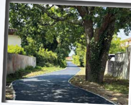
Les cyclistes disposent d'une nouvelle voie verte sécurisée entre l'Avenue de Mélac et la Rue Newton.
