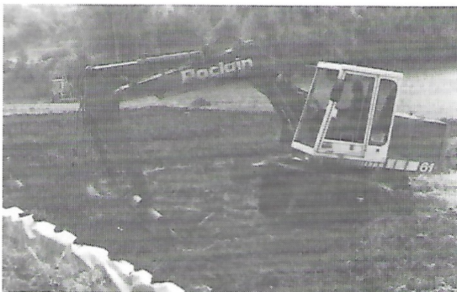
Début des travaux au nouveau cimetière
