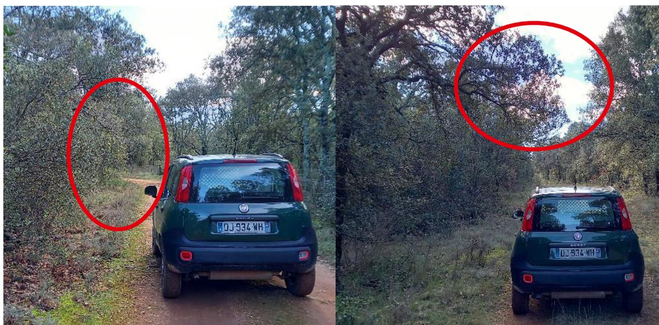
Gabarit réalisée partiellement avec des éléments à supprimer (cercle rouge) pour garantir un gabarit de 4m\*4m sans obstacle
