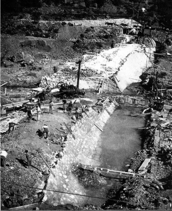
Edification du barrage *
