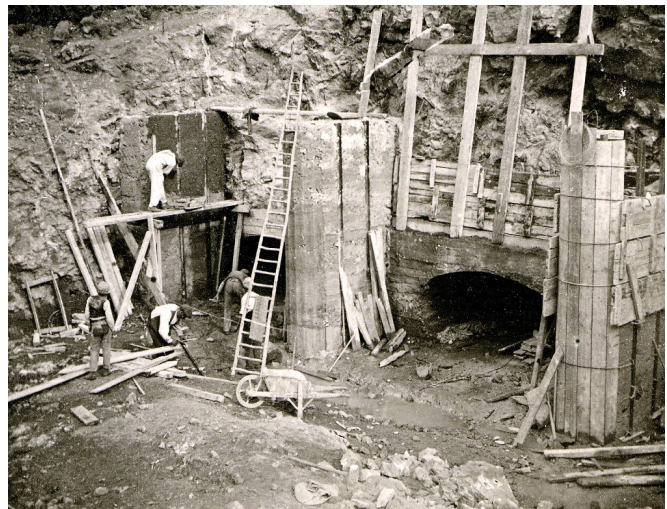
Galleries de sortie d'eau après les turbines *
