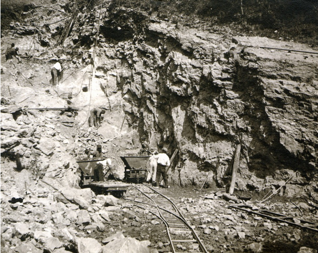
Travaux d'ancrage du barrage *
