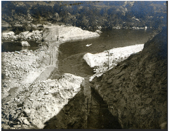
Dérivation des eaux *
