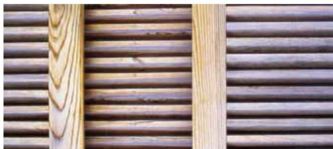
Bois posé à claire voie
