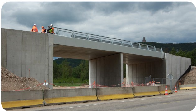
Chantier situé Route de Scherwiller (RD 35)
