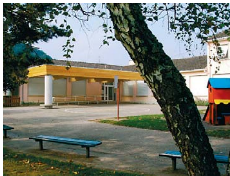
Construction d'un préau
