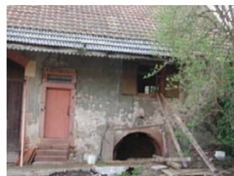
État avant rénovation
