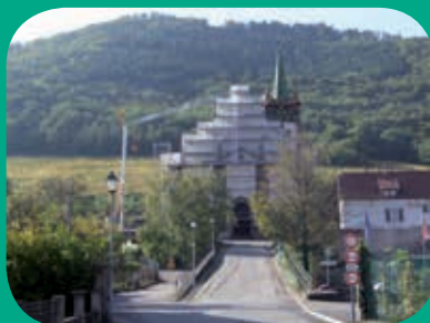
Travaux à l'Eglise Saint-Georges p5
