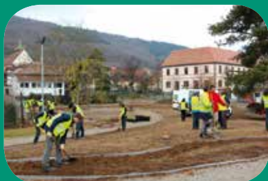
Travaux au Parc Ergée p.4
