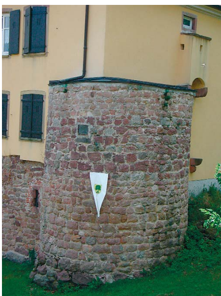
Tour d'angle nord-ouest de l'enceinte intérieure.
