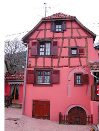
Fonts baptismaux gothiques de l'église médiévale, datés de 1401. Un béguinage (institution religieuse où des femmes souvent veuves vivaient en collectivité) est implanté contre le rempart dès 1411. La base de cette maison pourrait dater partiellement de ce béguinage.
