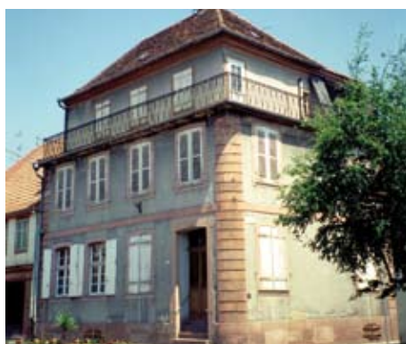
Auberge Zum Bock, Stadelhof, entre 1735 et 1742. Cette maison médiévale du XIII e siècle ou XIV e siècle est citée dès 1489.
