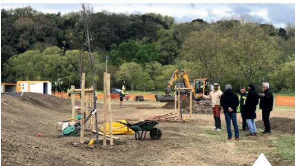
Un chantier confié à des spécialistes de la création de Pumptrack
