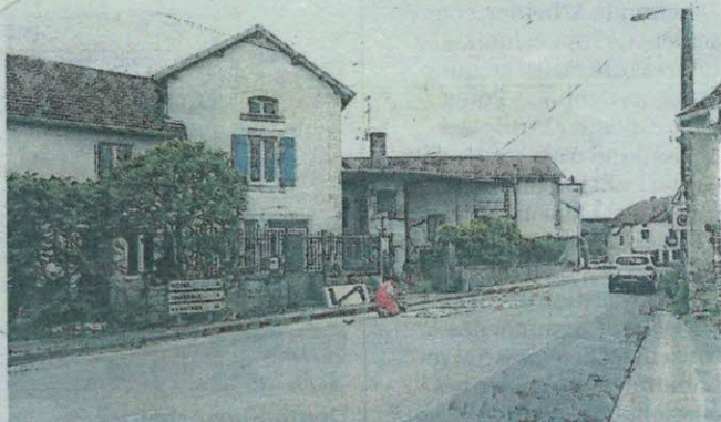
Les employés de la CCS Cyril Coghetto Signalisations ont effectué le marquage au sol de la zone 30. Photo Rémy Monget
