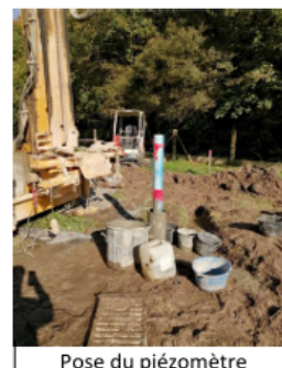
Pose du piézomètre
