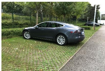
Privilégier les matériaux perméables, associant la présence d'herbe, ex. pavés avec joints enherbés ou système alvéolaire
