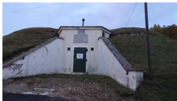
Réservoir - Route de Montceau
