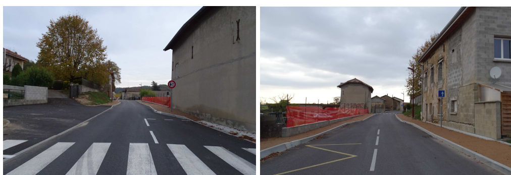
Travaux d'aménagement de la route de Châtonnay
