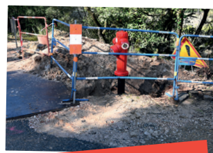
Installation de bornes à incendie Chemin des Signols
