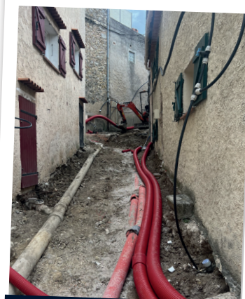
Travaux Rue du Professeur Roux
