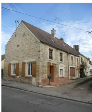
Maison rurale en moellons
