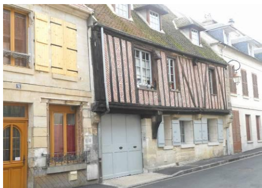
Maison à pans de bois et galandage en briques
