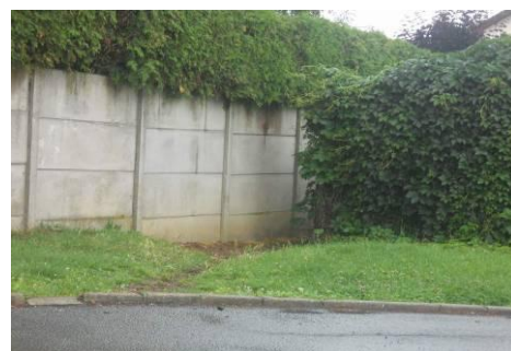
Sente piétonne à l'accès peu marqué et non entretenue
