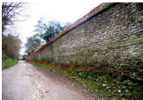
Continuité visuelle due aux murs de clôture
