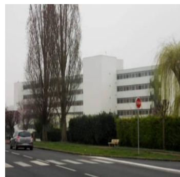
Construction en béton teinté
