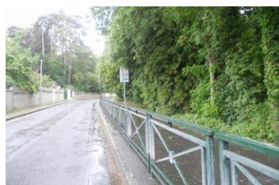
Aménagement sécurisé du trottoir aux abords du collège
