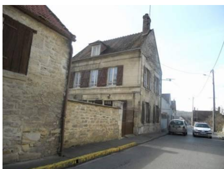
Maison de bourg à la volumétrie élancée en moellons et pierre de taille
