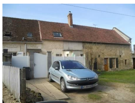
Granges en moellons réhabilitées
