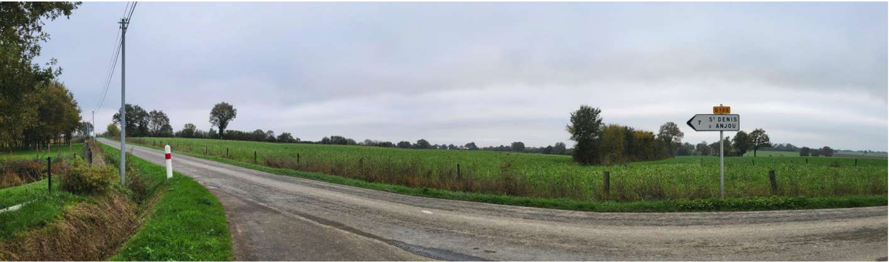
Vue 1 / Avant travaux
