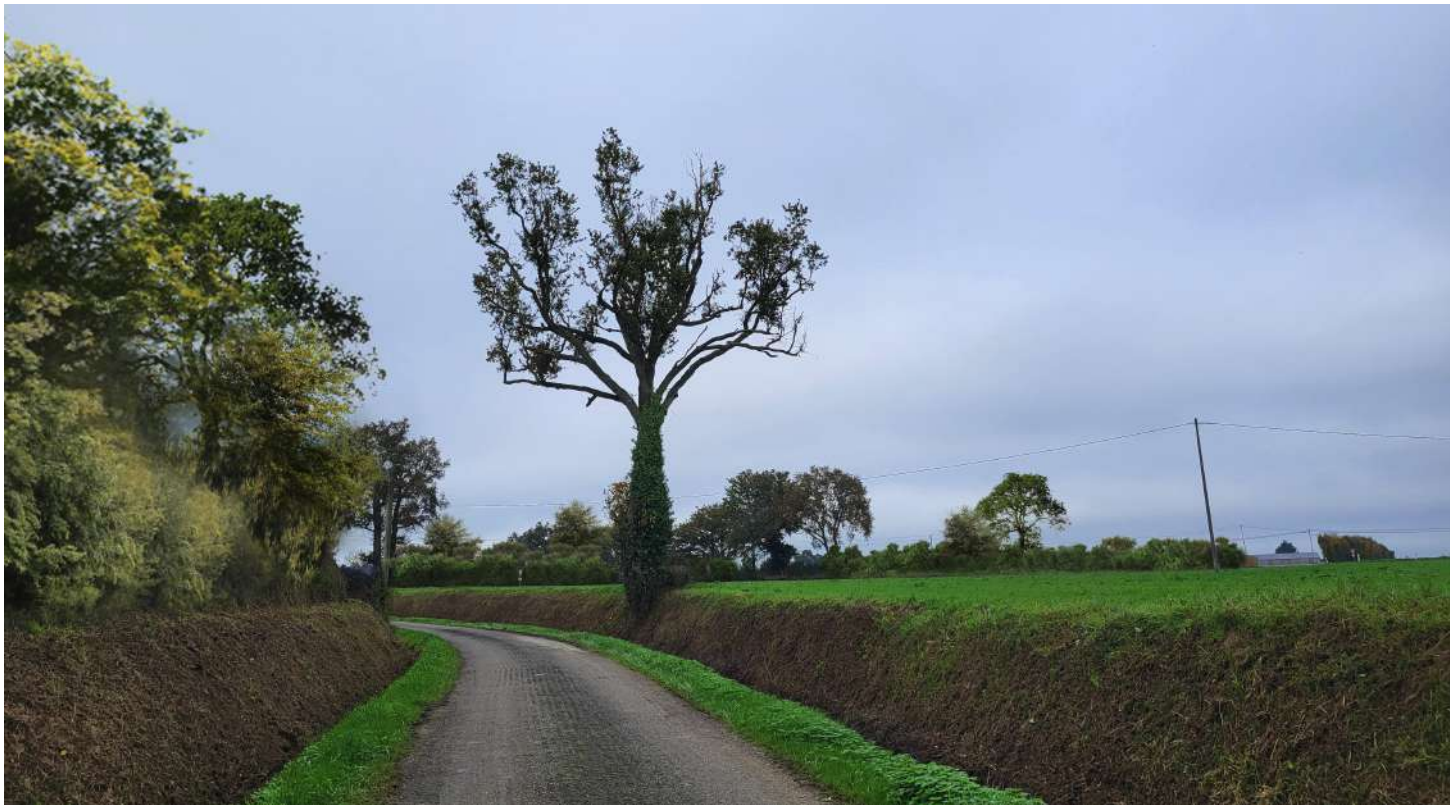
Vue 5 / Après travaux - avec mesures paysagères
