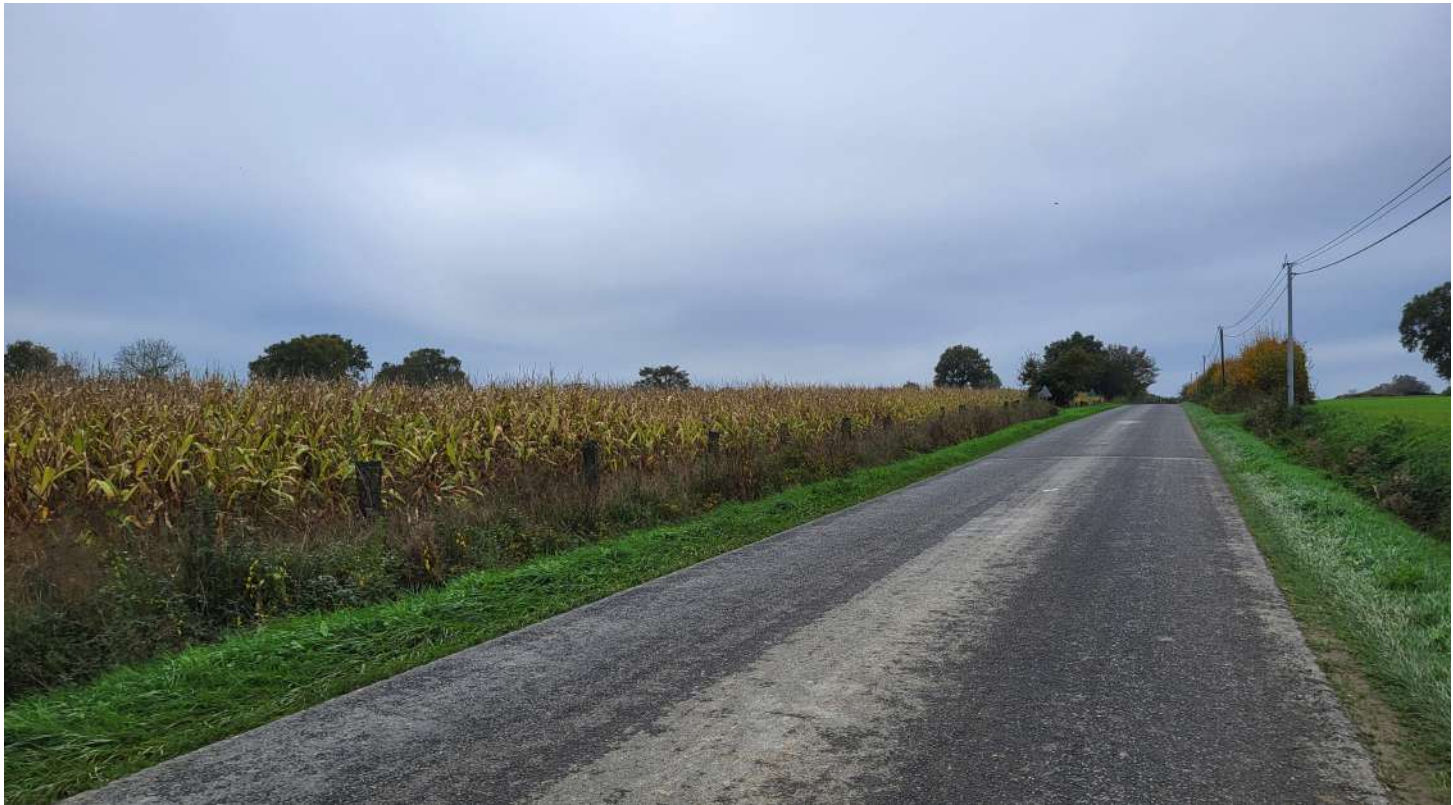
Vue 3 / Avant travaux
