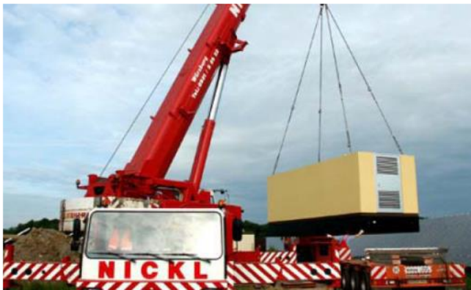
Figure 100 : Exemple d'acheminement d'un poste technique préfabriqué
