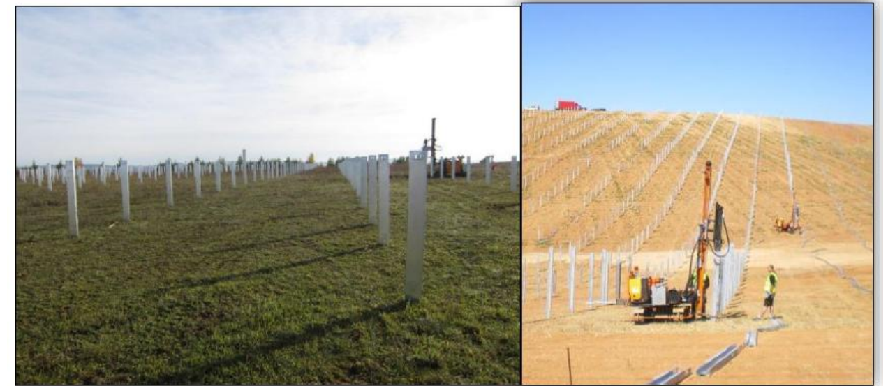
Figure 99 : Exemple de pieux battus dans le sol avec une batteuse visible en arrière-plan
