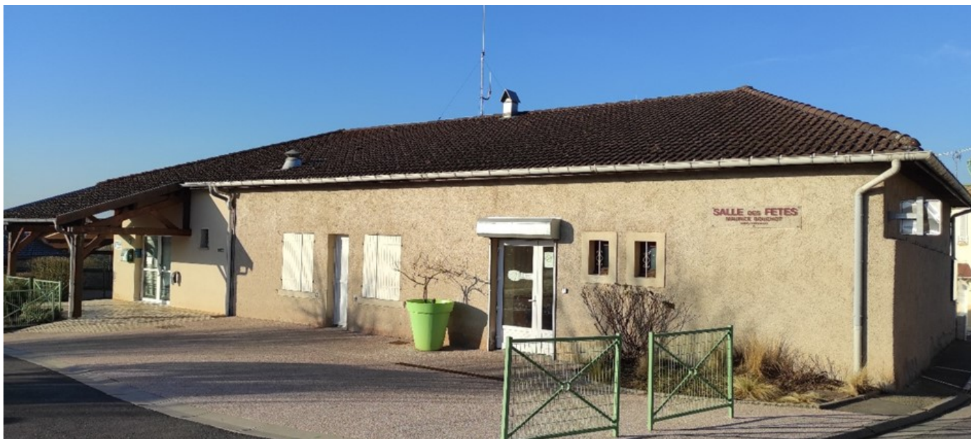
De gros travaux en prévision pour la salle Maurice Bouchot.
