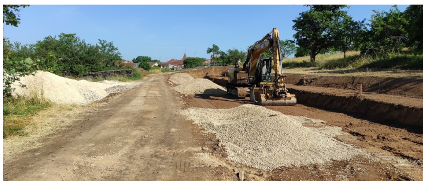
Début des travaux pour la future rue des Chenevières.
