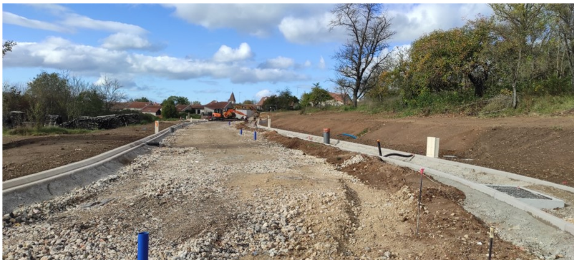
La rue des Chenevières en travaux
